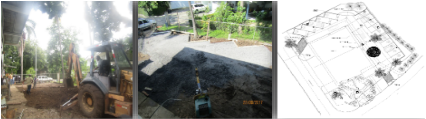
Acondicionamiento de estacionamientos en el Edificio 977.
