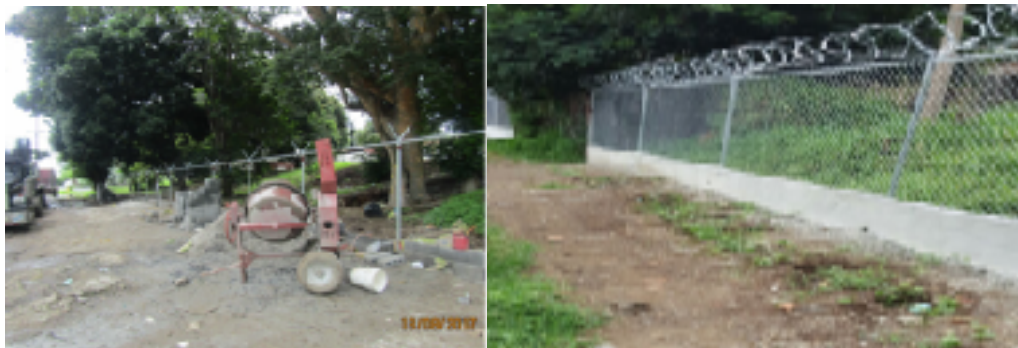
Construcción de cerca perimetral.
