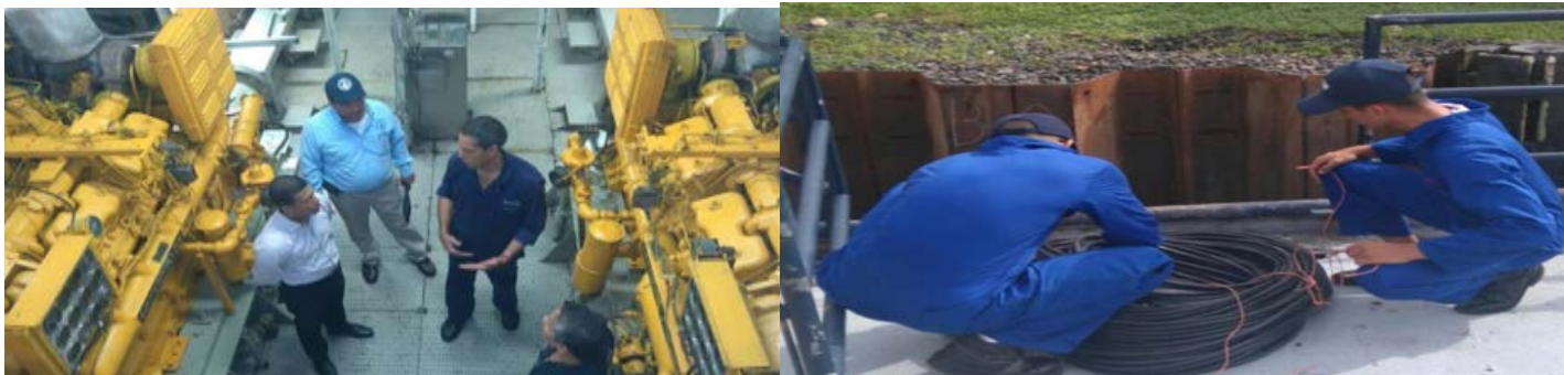
Trabajos de acondicionamiento en el buque escuela Atlas III
